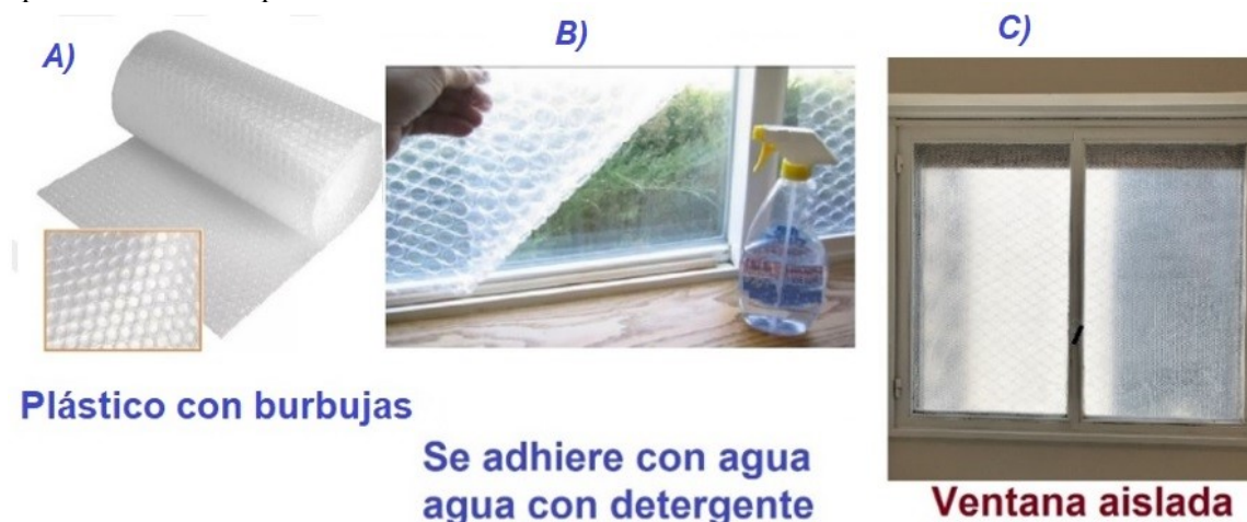
Figura 2: A) Plástico de burbujas o plástico alveolar para aislar las ventanas en el invierno o todo el año (izq). B) Forma de colocación (centro) y C) resultado final (der.). (Gil, 2023)
