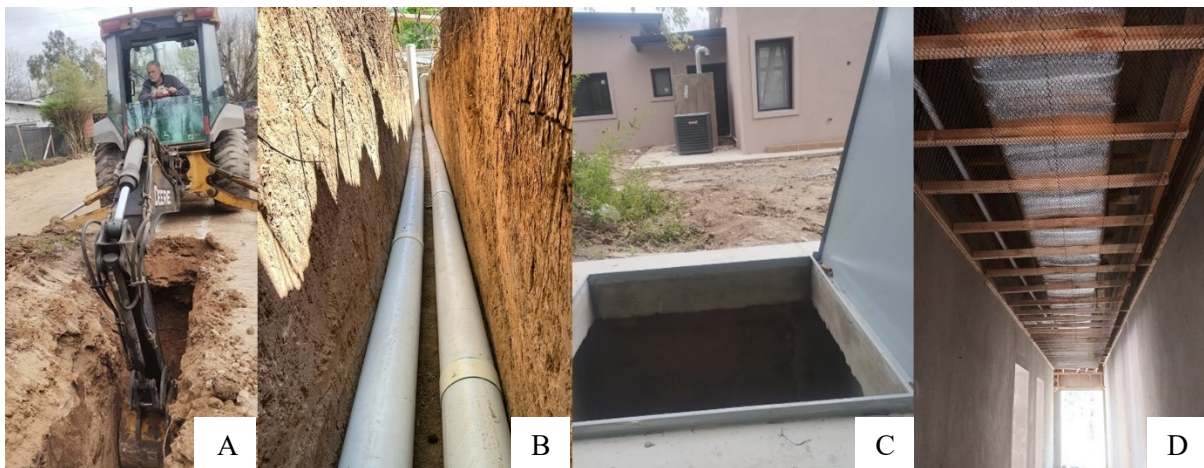
Figura 3: Construcción del pozo canadiense. A: retroexcavadora realizando la zanja. B: tuberías del intercambiador de calor. C: cámara de inspección y la toma de aire en el fondo. D: conductos de distribución en el cielorraso.
