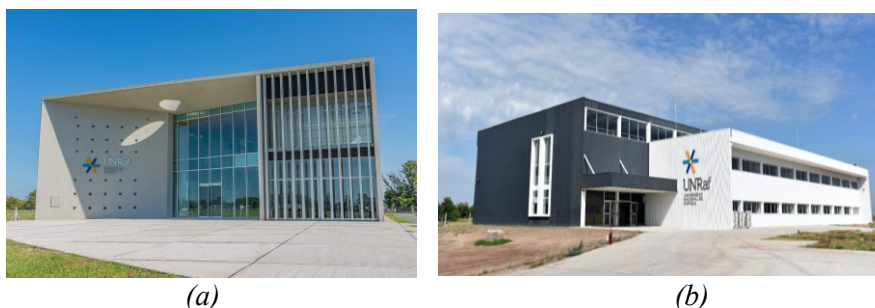
Figura 1: Imágenes de los edificios que componen el Campus de UNRaf, (a) Edificio 1., (b) Edificio 4.
