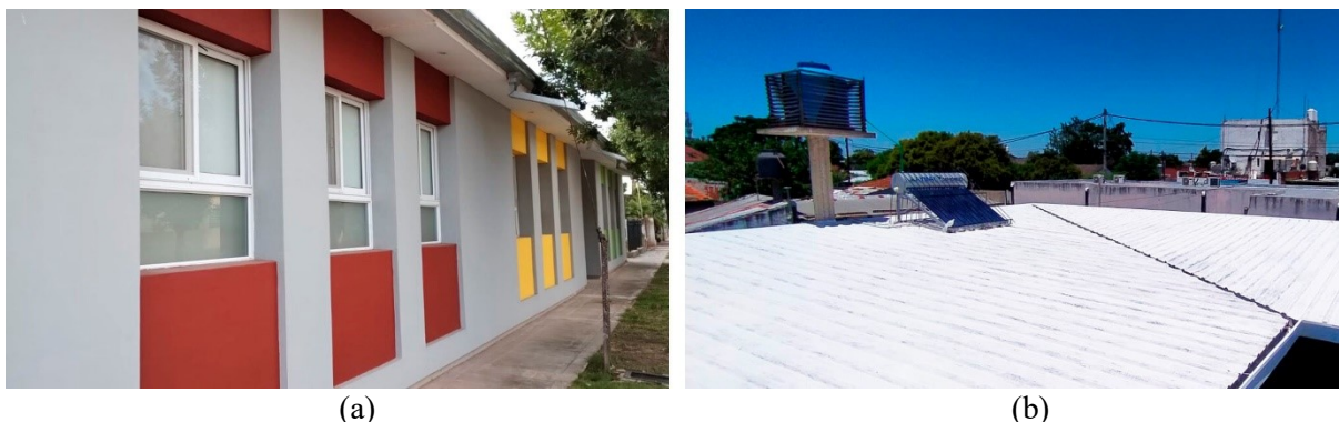
Figura 7: Final de obra, a) edificio del Jardín de Infantes N° 337 de San Carlos Sud y b) edificio del Centro de Desarrollo Infanto Familiar de San Miguel
