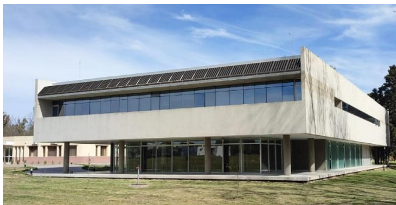
Figura 8: Instalación fotovoltaica incorporada en fachada. Instituto Dan Benisnson, CAE.
