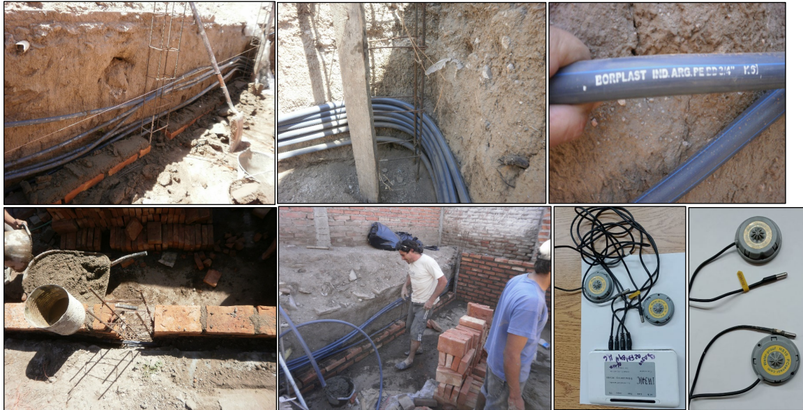
Figura 1: Imágenes de construcción de la piscina, datalogger y sensores de temperatura
