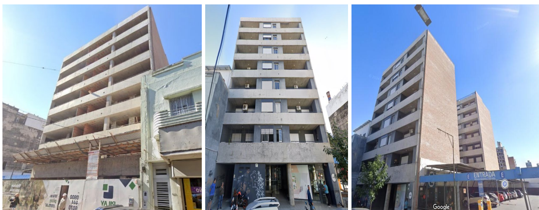
Figura 2: Imágenes edificio en construcción y finalizado
